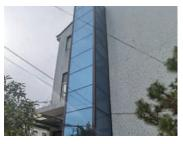
•與需要基礎吊裝的普通電梯不同, 不需要基礎吊裝,也減輕了大規模 的地板下挖掘工程。
